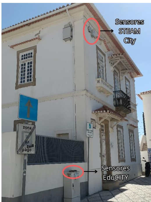
Figura 23 - Exemplo da disposição dos sensores durante as amostragens realizadas na Estação CP.
